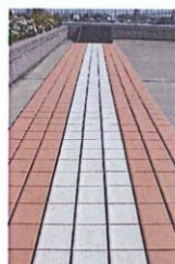
スロープとロックング歩道
